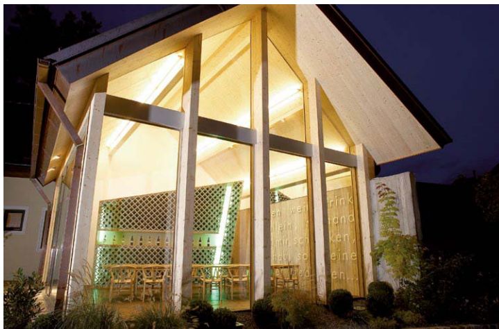
Abb. 3: Weingut Schabl: Durch die Linienstrukturen der verglasten Giebelfront bekommt der Verkaufsraum mit 55 m 2 Grundfläche den Eindruck von Größe.
